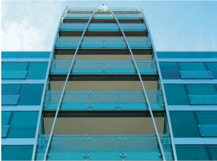
Die in den Spitz laufende Edelstahlrohre sind an die Betonstirne verankert. I tubi diagonali in acciaio inox con terminale a punta sono ancorati alle solette sporgenti in calcestruzzo.
