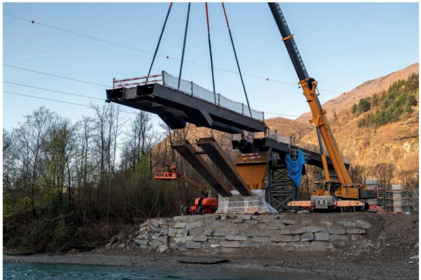
costituisce il tamponamento laterale. Due canali laterali, integrati nella struttura, formano il sistema di raccolta delle acque meteoriche longitudinale.
