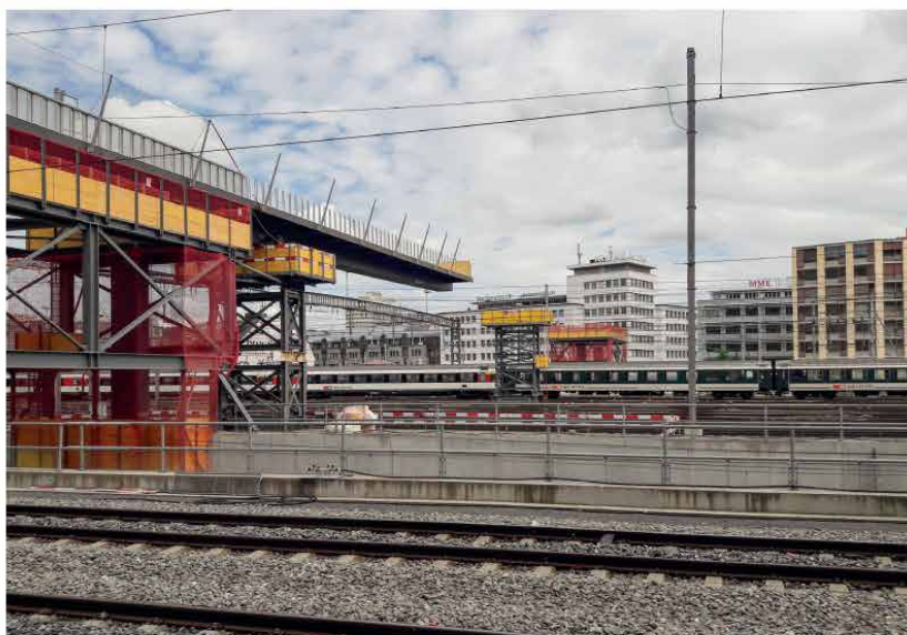
▲ Corpo della passerella in una delle fasi di varo, con il becco a spingere fino a 40 m a sbalzo sopra i binari. In primo piano e sullo sfondo i grandi portali tralicciati sopra le rampe d'accesso alle stazioni sotterranee, al centro altre torrette di supporto provvisorie.
