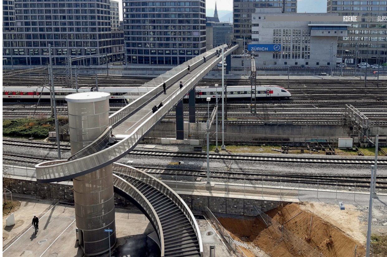
▲ La piattabanda della passerella confluisce alle due estremità nel corpo delle scale d'accesso a forma di chiocciola, che a loro volta avvolgono le torrette lift di forma cilindrica.
