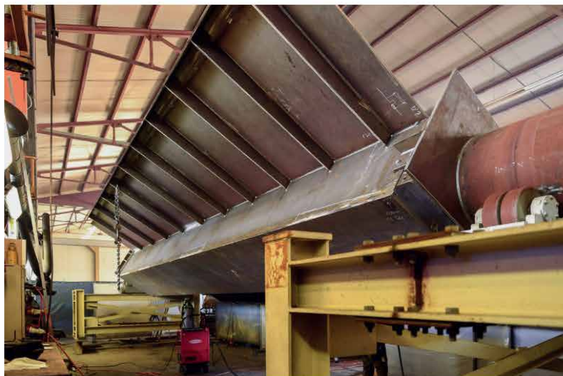
Intelaiatura rotante per un'esecuzione in posizione ottimale delle saldature del corpo della passerella, con spessori delle lamiere fino a 60 mm.
