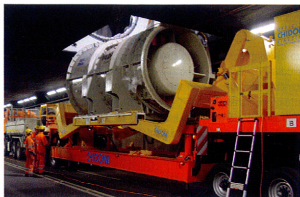
ATTREZZATURA PER SMONTAGGIO VENTILATORI
