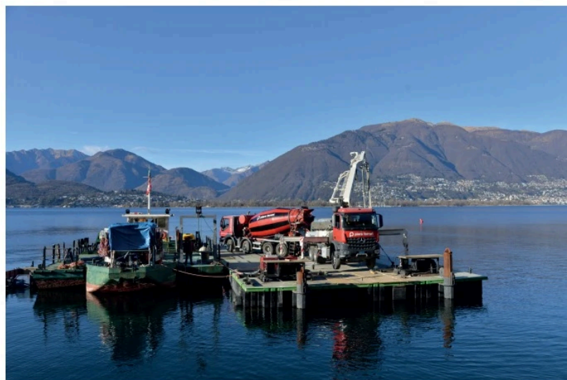
▲ Infrastruttura per esecuzione lavorazioni subacquee.
