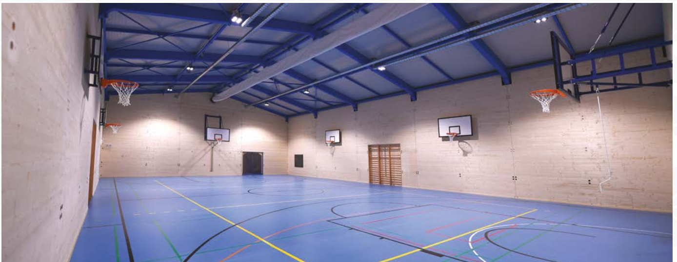
Vista interna della struttura adibita a palestra
