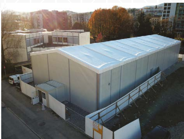
Vista esterna della struttura
