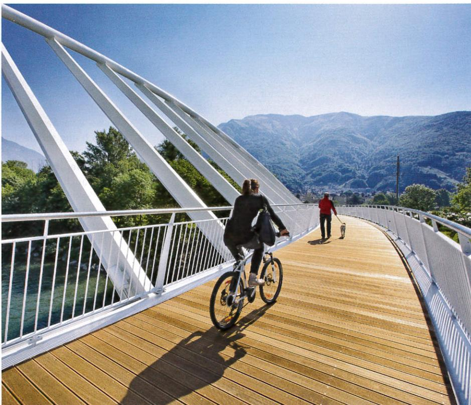
Die Fahrbahnplatte ist an der Kreuzung mit dem Bogen befestigt und ruht auf den Brückenpfeilern. Il piano pedonale-ciclabile è fissato all'incrocio con l'arco e poggia sui pilastri del ponte.
