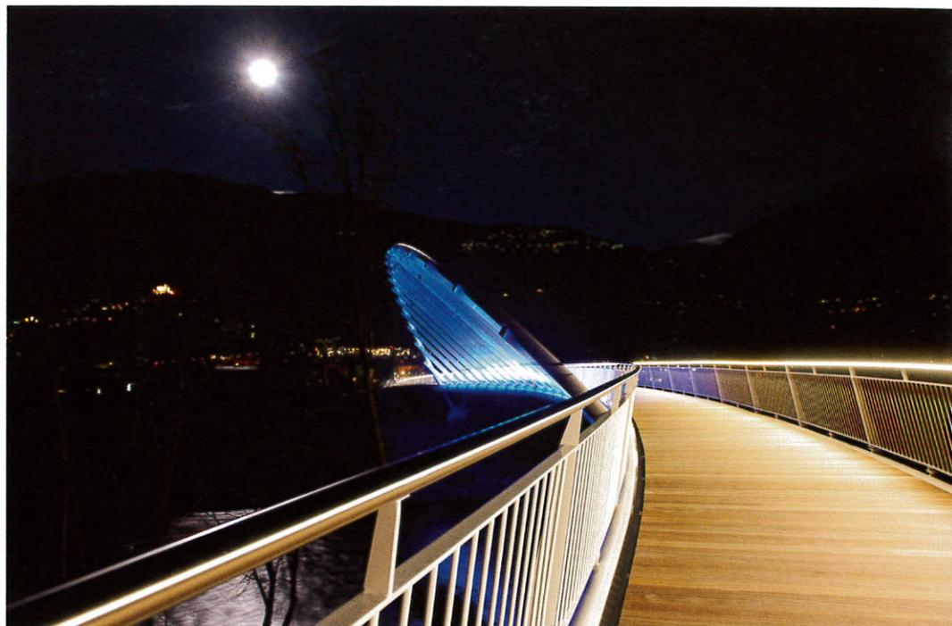
Die Beleuchtung wird durch LED-Lampen im Handlauf des Geländers und mit Spots an den Bogenpfeilern gewährleistet.
