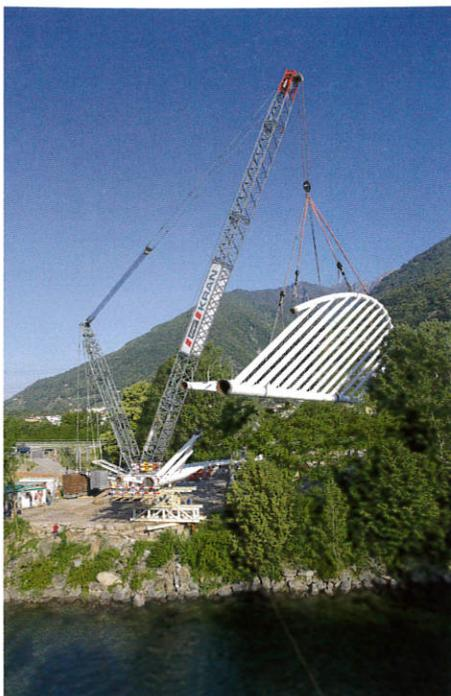
Das 50 Meter lange Mittelteil mit dem Bogen ist als einzelnes Element gebaut.
