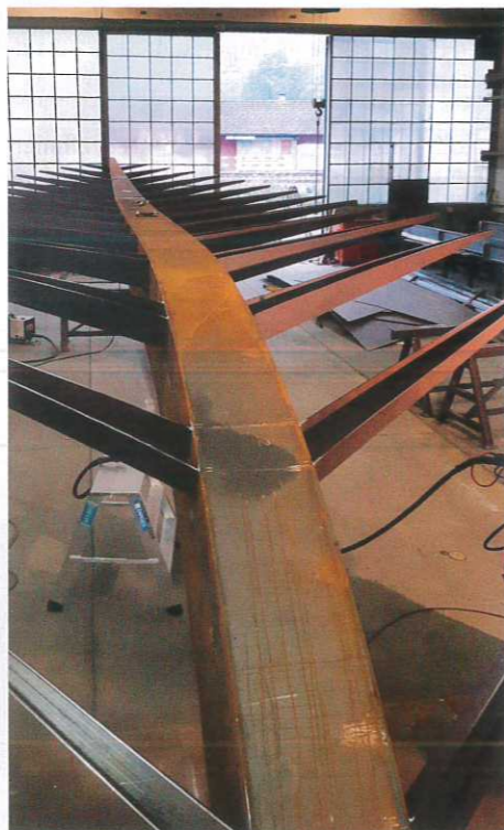
Im Werk: Die Seitenrippen werden an den Kastanienträger (Stiel) angeschweisst. In officina: i rami sono stati saldati alla trave scatolata (gambo).
