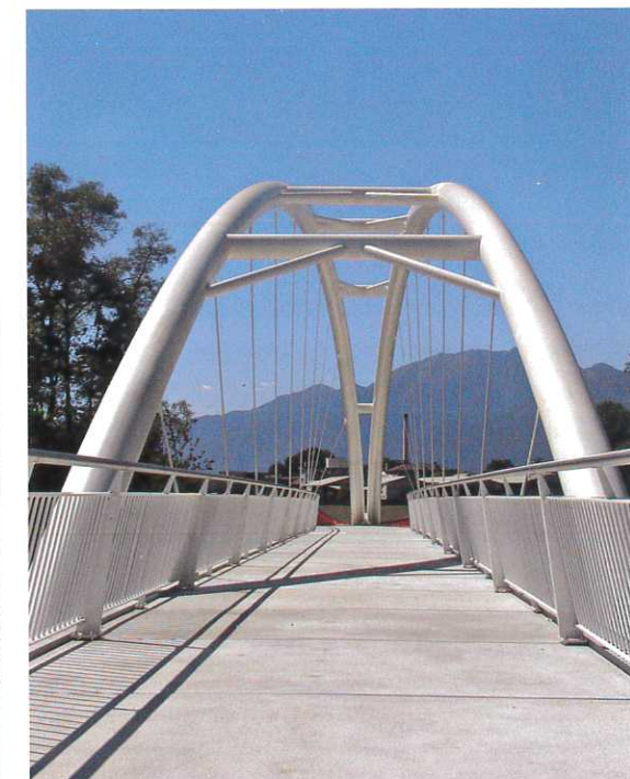
Die beiden parallel geführten Bögen sind leicht zueinander geneigt, spannen sich im Mittelfeld der Brücke auf und laufen am Ende wieder zusammen.
